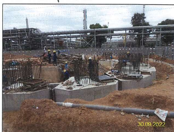
ข) การปรับสภาพพื้นที่และก่อสร้างฐานรากในกิจกรรมก่อสร้างการติดตั้งถังเก็บพักโพรเพน/ แอลพีจีเพิ่มเติม จำนวน 2 ถัง
