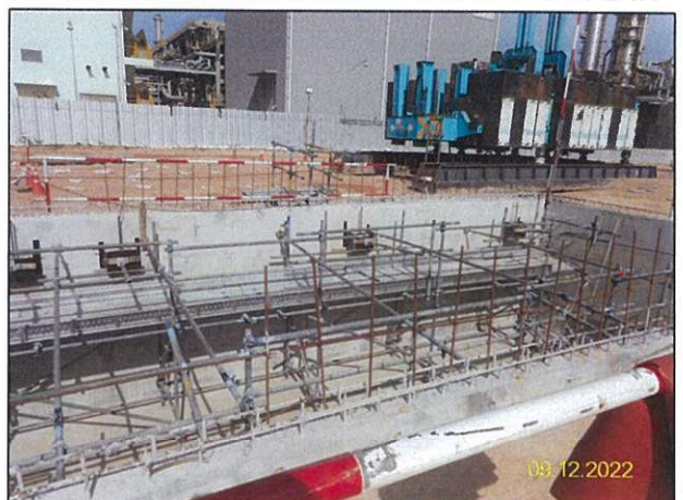
ค) การฉาบปูนผิวบ่อในกิจกรรมก่อสร้างการติดตั้งหน่วยกำจัดกลิ่นแบบอาร์ทีโอ (Regenerative Thermal Oxidizer; RTO) และ SO 2 Scrubber
