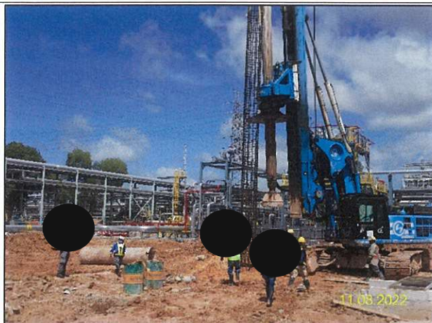
ก) การตอกเสาเข็มในกิจกรรมก่อสร้างการติดตั้งถังเก็บพักโพรเพน/แอลพีจีเพิ่มเติม จำนวน 2 ถัง
