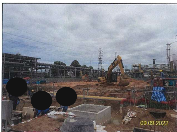
ข) การปรับสภาพพื้นที่และก่อสร้างฐานรากในกิจกรรมก่อสร้างการติดตั้งถังเก็บพักโพรเพน/ แอลพีจีเพิ่มเติม จำนวน 2 ถัง
