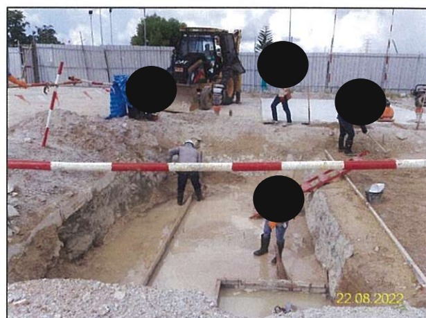
ข) การก่อสร้างฐานรากในการก่อสร้างกิจกรรมก่อสร้างติดตั้งระบบระบายน้ำทิ้งจากการดักจับ ก๊าซซัลเฟอร์ไดออกไซด์ (Zero Liquid Discharge; ZLD)
