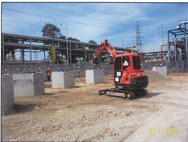
ข) การปรับปรุงพื้นที่และการก่อสร้างรางระบายน้ำในกิจกรรมก่อสร้างการติดตั้งถังเก็บพักโพเทน/แอลพีจีเพิ่มเติม จำนวน 2 ถัง
