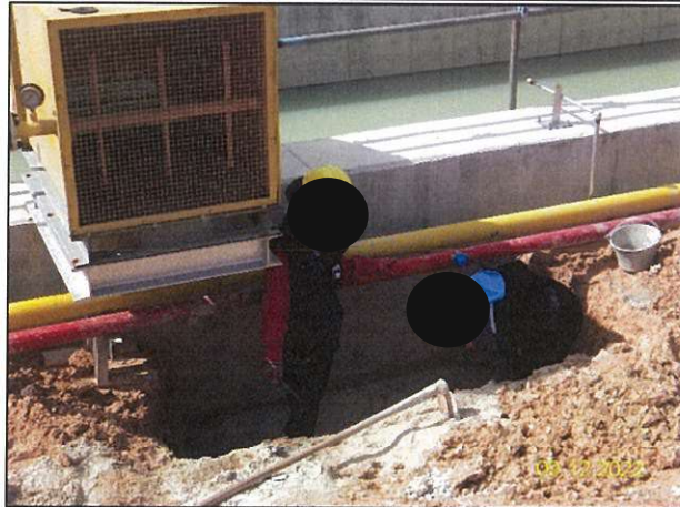
ก) การเคลื่อนคอนกรีตฐานรากและการเชื่อมฐานรองรับท่อในกิจกรรมการก่อสร้างบ่อควบคุมระยะไกล
