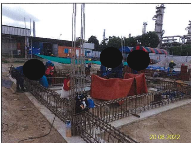
ข) การก่อสร้างฐานรากในการก่อสร้างกิจกรรมก่อสร้างติดตั้งระบบระบายน้ำทิ้งจากการดักจับ ก๊าซซัลเฟอร์ไดออกไซด์ (Zero Liquid Discharge; ZLD)
