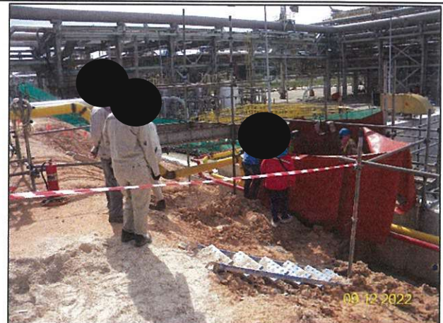
ก) การเคลื่อนคอนกรีตฐานรากและการเชื่อมฐานรองรับท่อในกิจกรรมการก่อสร้างบ่อควบคุมระยะไกล
