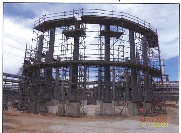
ข) การติดตั้งโครงสร้างฐานรองรับถังในกิจกรรมก่อสร้างการติดตั้งถังเก็บพักโพรเพน/แอลพีจีเพิ่มเติม จำนวน 2 ถัง
