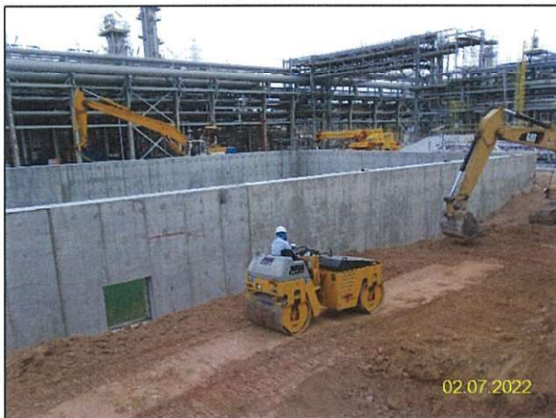
ข) การบดอัดดินและเทพื้นคอนกรีตในกิจกรรมก่อสร้างบ่อควบคุมระยะไกล
