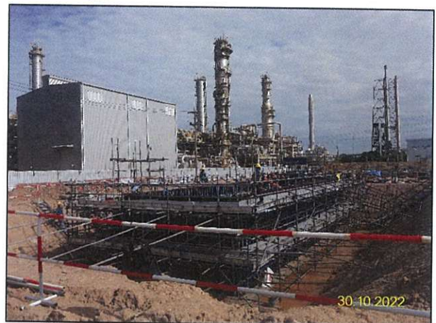
ค) การติดตั้งนั่งร้านในกิจกรรมก่อสร้างการติดตั้งหน่วยกำจัดกลิ่นแบบอาร์ทีโอ (Regenerative Thermal Oxidizer; RTO) และ SO 2 Scrubber
