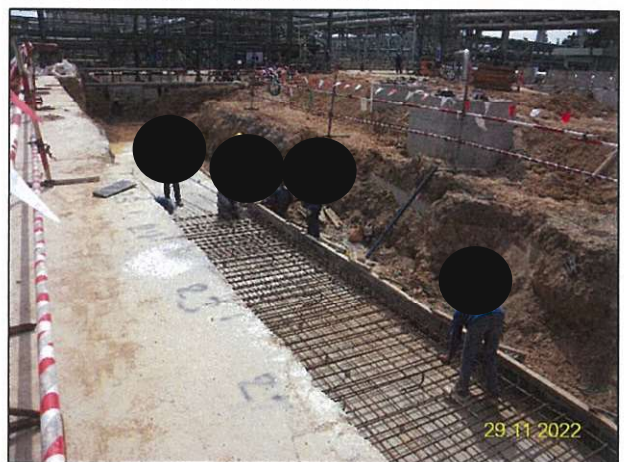
ข) การปรับปรุงพื้นที่และการก่อสร้างรางระบายน้ำในกิจกรรมก่อสร้างการติดตั้งถังเก็บพักโพเทน/แอลพีจีเพิ่มเติม จำนวน 2 ถัง
