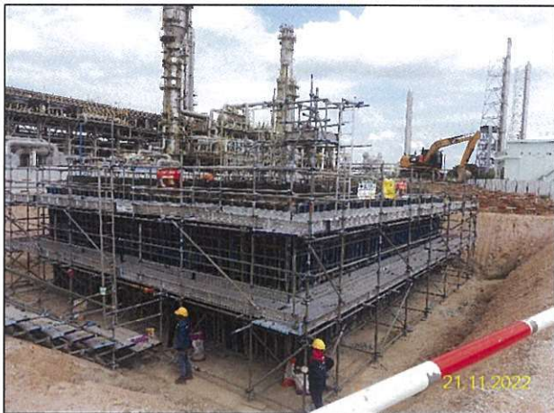
ค) การติดตั้งนั่งร้านและไม้แบบในการก่อสร้างกิจกรรมก่อสร้างการติดตั้งหน่วยกำจัดกลิ่นแบบอาร์ทีโอ (Regenerative Thermal Oxidizer; RTO) และ SO 2 Scrubber
