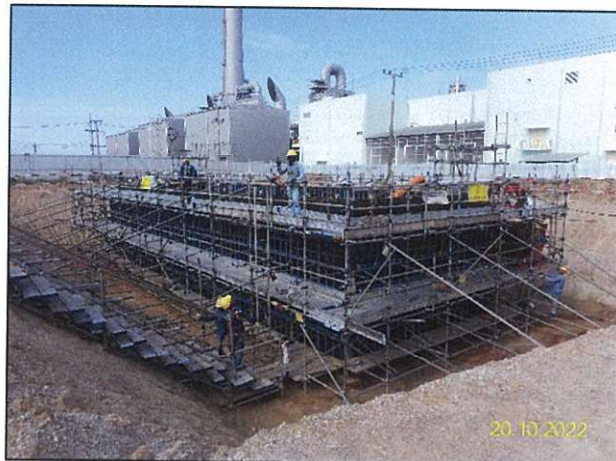
ค) การติดตั้งนั่งร้านในกิจกรรมก่อสร้างการติดตั้งหน่วยกำจัดกลิ่นแบบอาร์ทีโอ (Regenerative Thermal Oxidizer; RTO) และ SO 2 Scrubber
