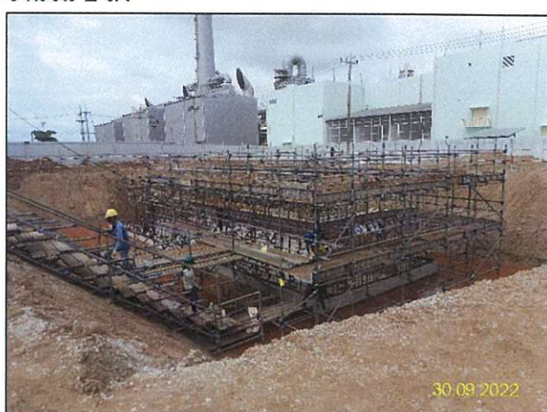
ค) การเทพื้นปูนและการติดตั้งนั่งร้านในกิจกรรมก่อสร้างการติดตั้งหน่วยกำจัดกลิ่นแบบอาร์ทีโอ (Regenerative Thermal Oxidizer; RTO) และ SO 2 Scrubber
