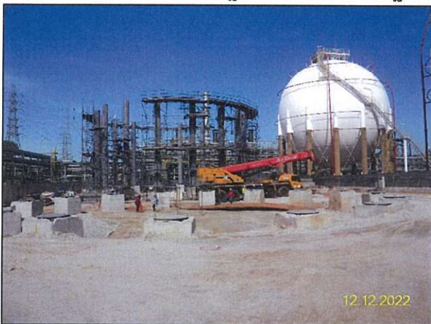
ข) การติดตั้งโครงสร้างฐานรองรับถังในกิจกรรมก่อสร้างการติดตั้งถังเก็บพักโพรเพน/แอลพีจีเพิ่มเติม จำนวน 2 ถัง
