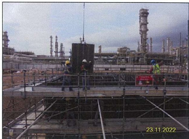
ค) การติดตั้งนั่งร้านและไม้แบบในการก่อสร้างกิจกรรมก่อสร้างการติดตั้งหน่วยกำจัดกลิ่นแบบอาร์ทีโอ (Regenerative Thermal Oxidizer; RTO) และ SO 2 Scrubber
