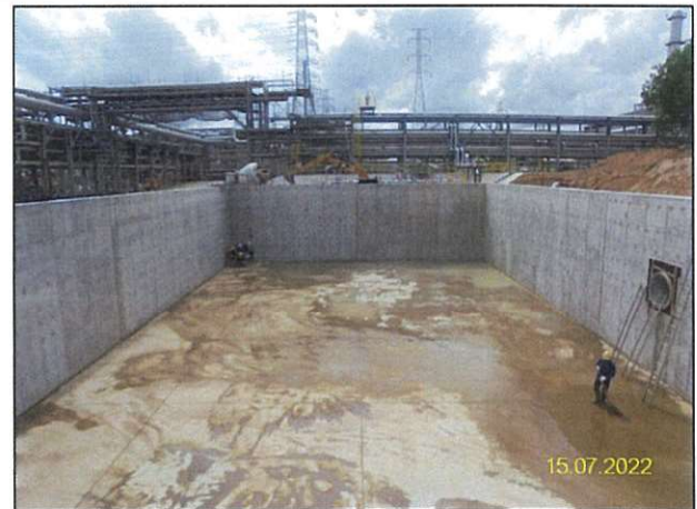
ข) การบดอัดดินและเทพื้นคอนกรีตในกิจกรรมก่อสร้างบ่อควบคุมระยะไกล
