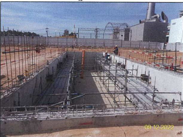
ค) การฉาบปูนผิวบ่อในกิจกรรมก่อสร้างการติดตั้งหน่วยกำจัดกลิ่นแบบอาร์ทีโอ (Regenerative Thermal Oxidizer; RTO) และ SO 2 Scrubber
